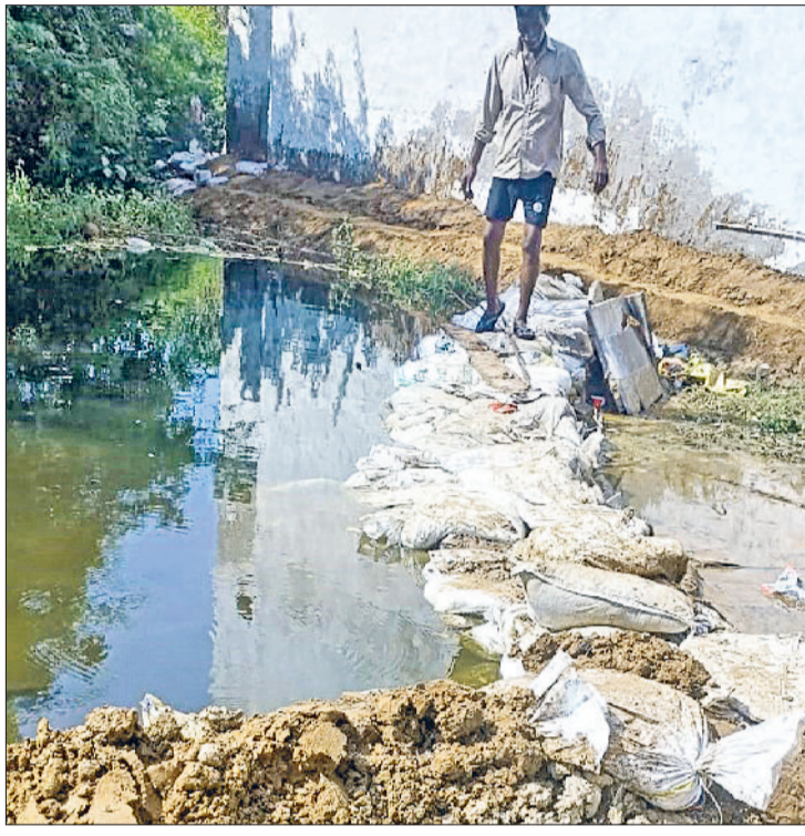
बहादुरगढ़। पानी रोकने के लिए मुंगेशपुर ड्रेन के किनारे पर कट्टे लगाते लोग।
